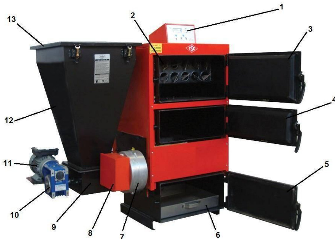
Рисунок 2. Котел EK3G/S 30-100 трехходовая конвективная часть
