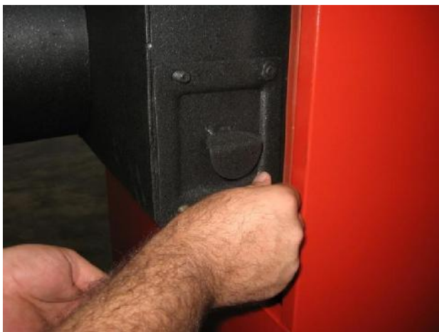
Рисунок 15. Снятие заглушки для чистки адаптера дыма
